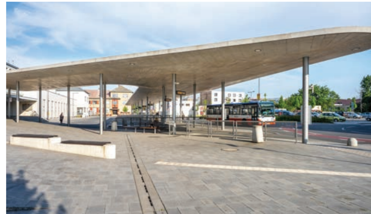
IROP – Modernizace přestupního terminálu v Kolině, Středočeský kraj
